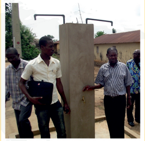
Eine elektrische Wasserpumpe
